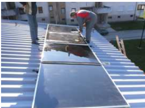
Postavljanje solarnih panela na gradsku toplanu
